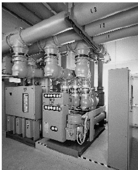
Рис. 3.1: Расширение КРУЭ одинарной системой шин
