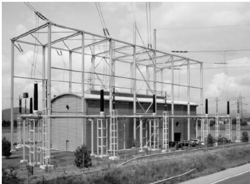
Рис. 7.2: КРУЭ на 420 кВ
