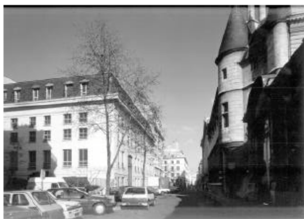
Рис. 2.3: КРУЭ на 245 кВ с трансформаторами и с оборудованием на среднее напряжение 24 кВ, скрытое в здании, стилизованном под жилой дом (слева)
