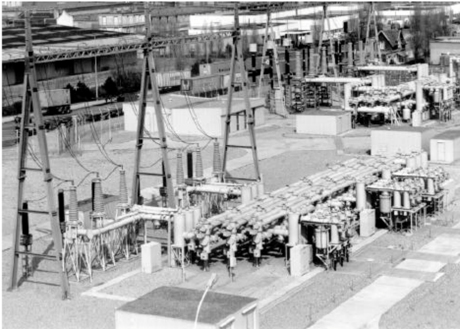
Рис. 2.1: Наружная подстанция КРУЭ на 245 кВ с воздушной линией передачи и кабельными соединениями
