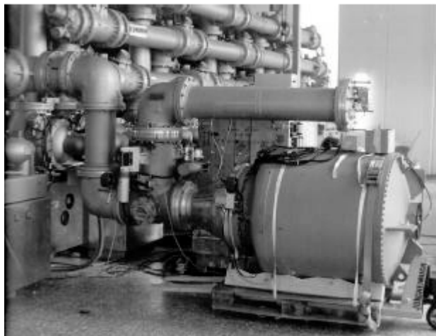
Рис. 10.2: Испытательный трансформатор с элегазовой изоляцией и разделительный конденсатор для измерения ЧР, подключенные напрямую к КРУЭ
