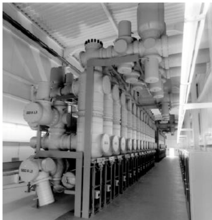
Рис. 3.3: Внутренняя подстанция КРУЭ на 420 кВ
